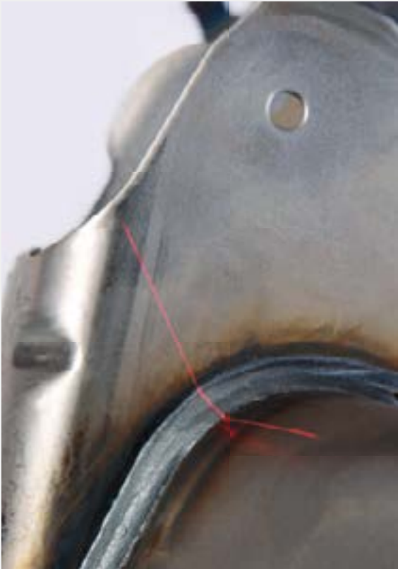
스틸 용접 비드의 검사
